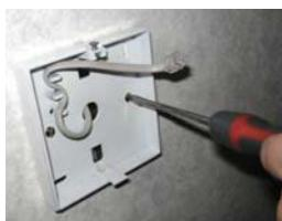
Пропустите кабель дистанционного управления RJ через одно из отверстий на задней части корпуса и закрепите его, зафиксируйте заднюю часть корпуса к соединительной коробке при помощи крепежных винтов 2 x M3.5 (не поставляются).
