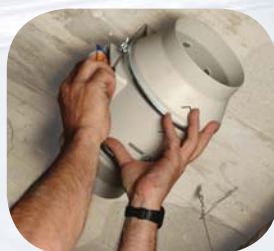
Установите корпус вентилятора
